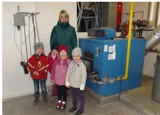
Die Heizung funktioniert wieder!! Frohe Gesichter bei den Kindern und der Chefin.
